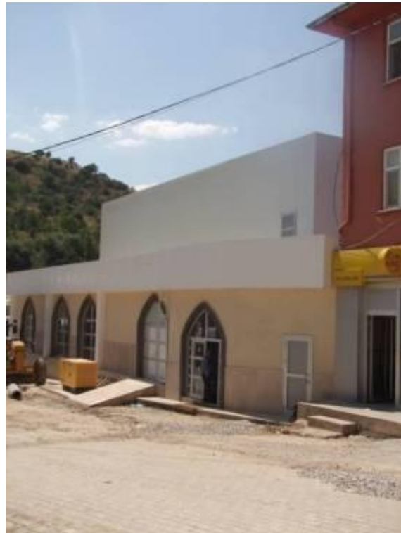
Fotoğraf:165- Atatürk Caddesi Üzerinde Yer Alan 116/1-3 Parseldeki Yapıdan Görünüm
