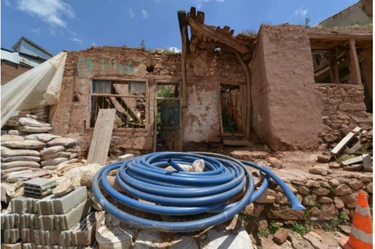
Fotoğraf:140- Başara Caddesi Üzerinde Yer Alan 3/A Numaralı Yapıdan Görünüş
