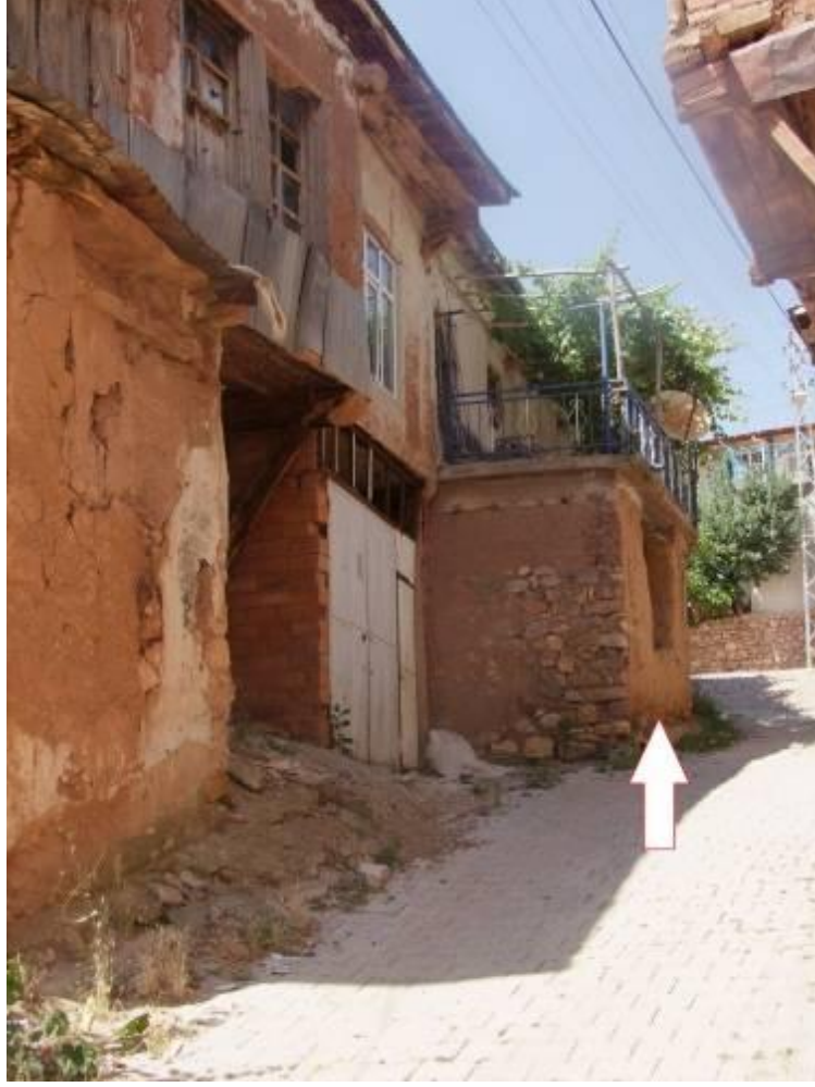
Fotoğraf:115- 6-6 Cephesi 22/A Numaralı Evin Balkonundan Görünüş
