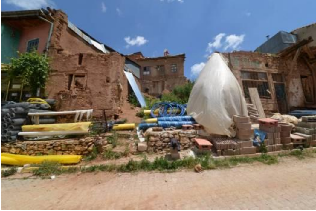
Fotoğraf:139- Başara Caddesi Üzerinde Yer Alan 3/A Numaralı Yapıdan Görünüş
