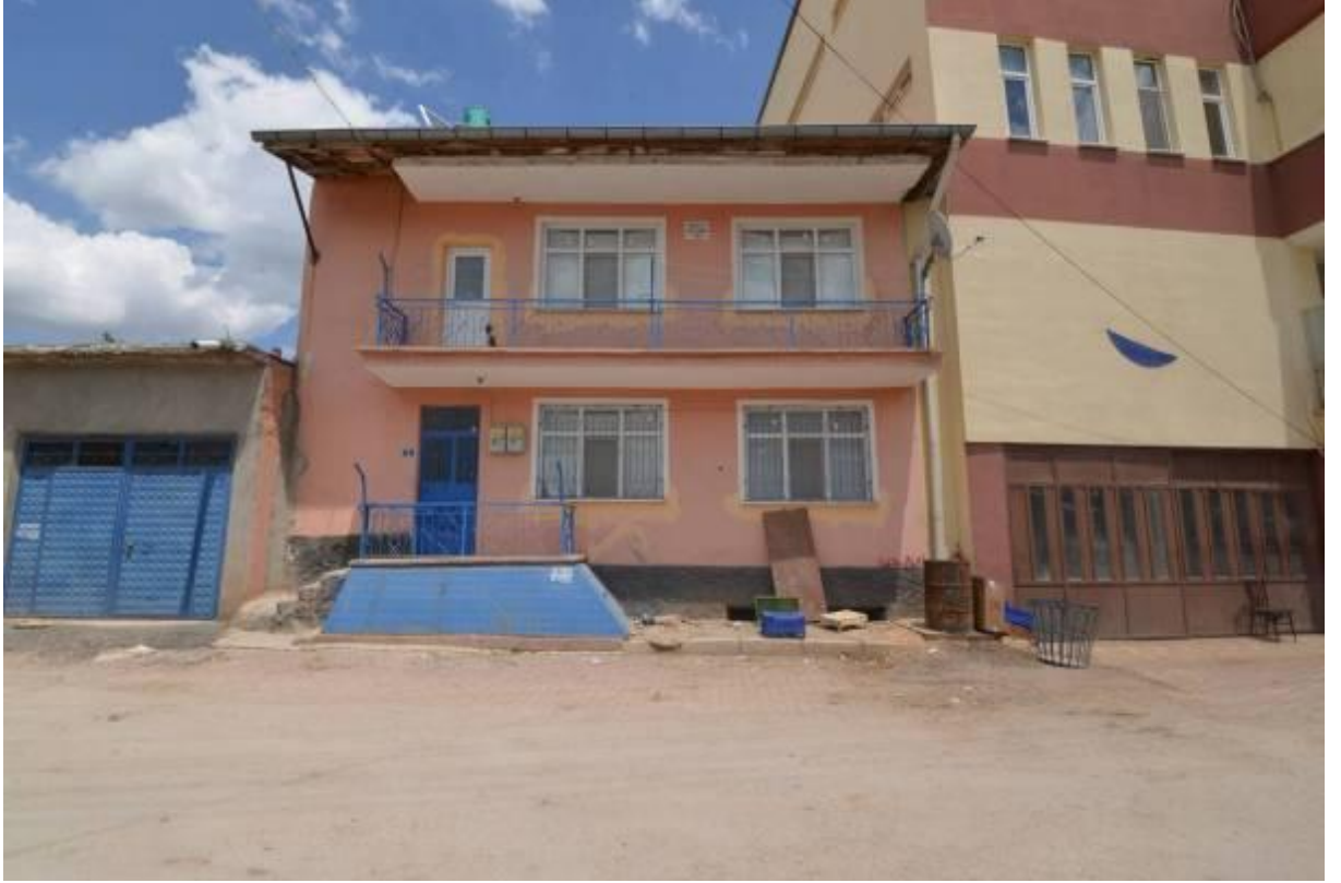
Fotoğraf:36- 4 Numaralı Evin Caddeye Bakan Cephesi
