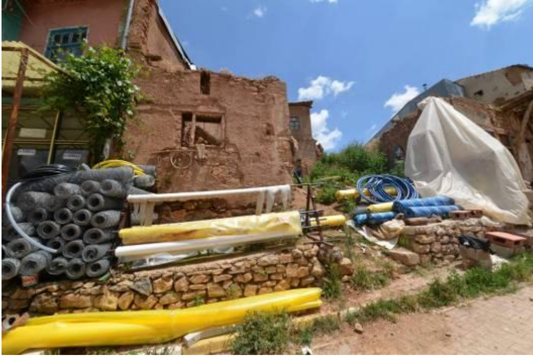
Fotoğraf:138- Başara Caddesi Üzerinde Yer Alan 3/A Numaralı Yapıdan Görünüş
