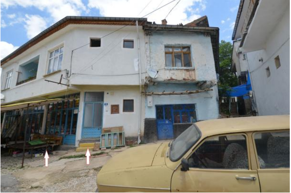
Fotoğraf:72- Konya Caddesi Üzerinde 10 Numaralı Yapının Giriş Kapısı
