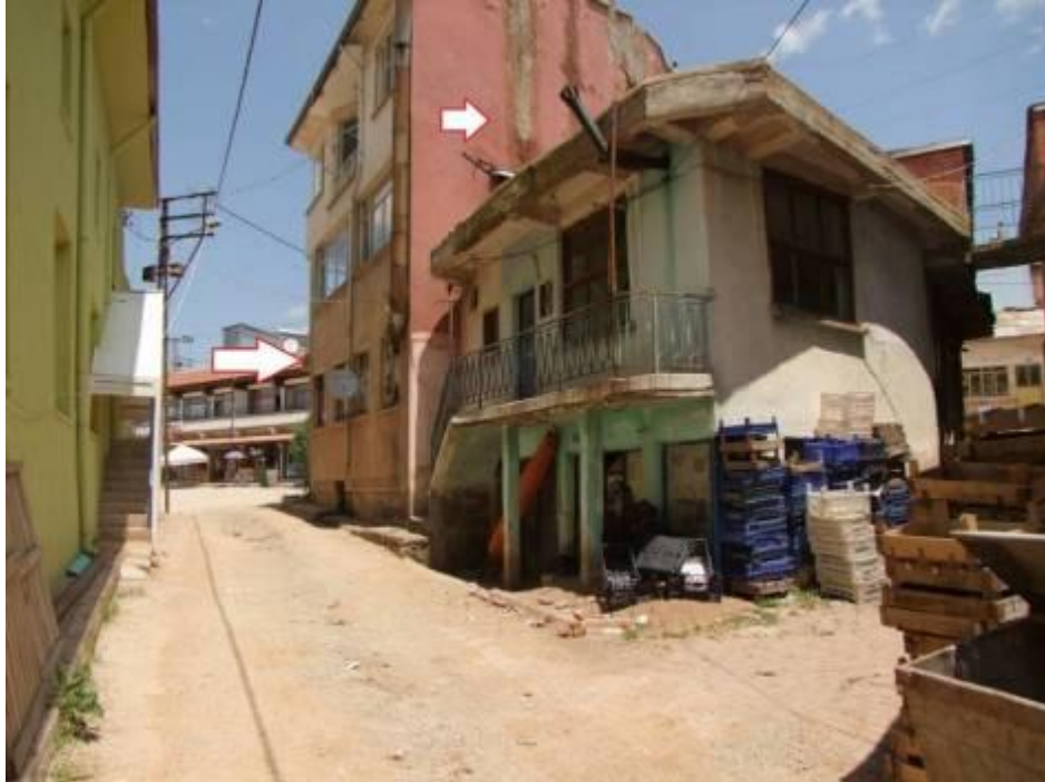
Fotoğraf:121- 6-6 Cephesinde ki Yapının Güney Cephesi
