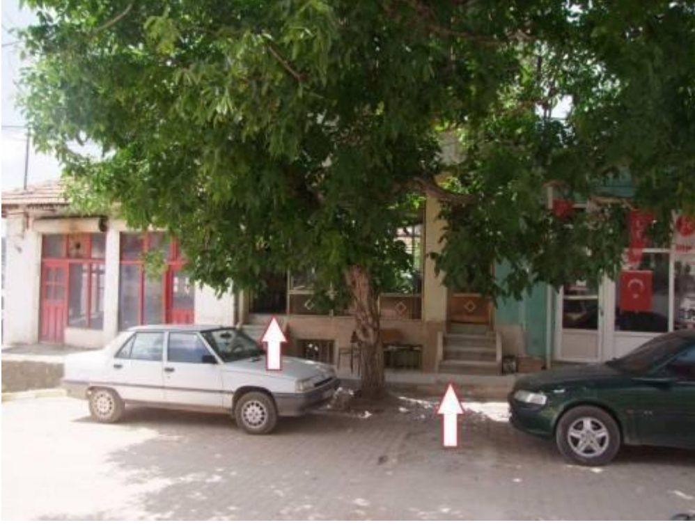
Fotoğraf:151- Başara Caddesi Üzerinde Yer Alan 121/8-9 Parselinde Yapıdan Görünüm
