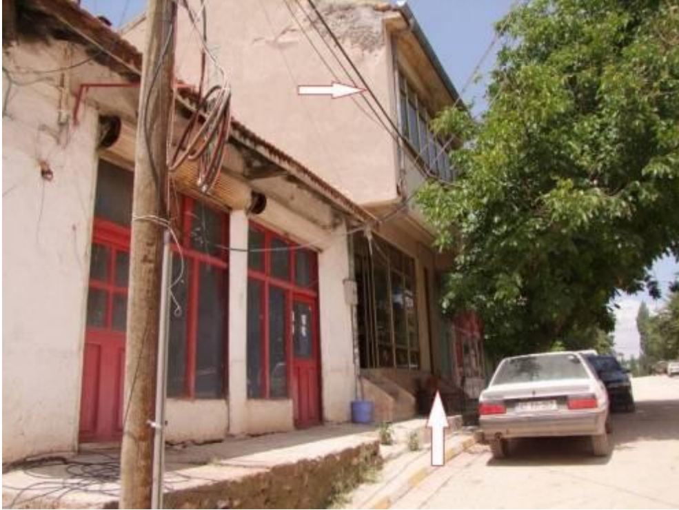
Fotoğraf:152- Başara Caddesi Üzerinde Yer Alan 121/8-9 Parselinde Yapıdan Görünüm
