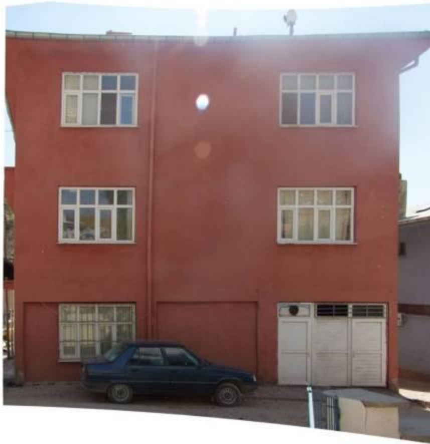
Fotoğraf:57- Kaymakamlık Binasının Kent Meydanına Bakan Cephesi
