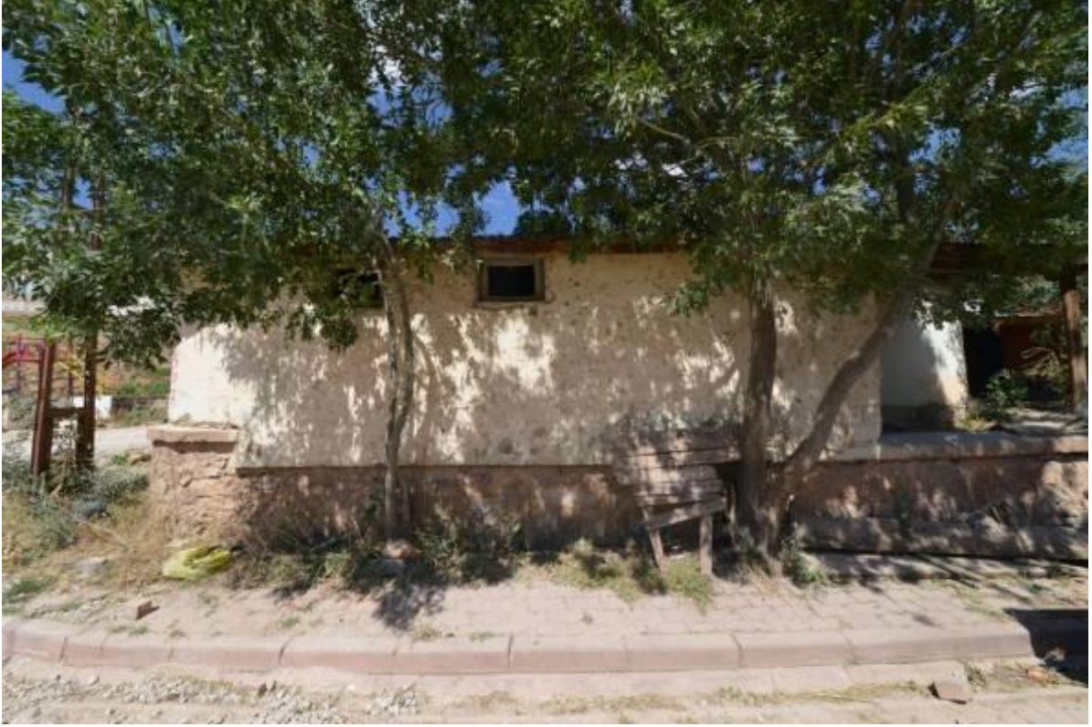
Fotoğraf:124- Başara Caddesi Üzerinde Yer Alan 18/A Numaralı Yapıdan Görünüş
