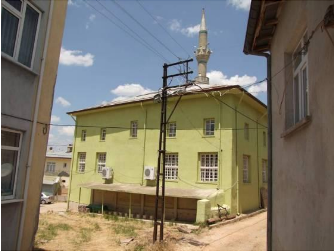
Fotoğraf:88- Derbent Büyük Cami Güney Cephe Görünüm
