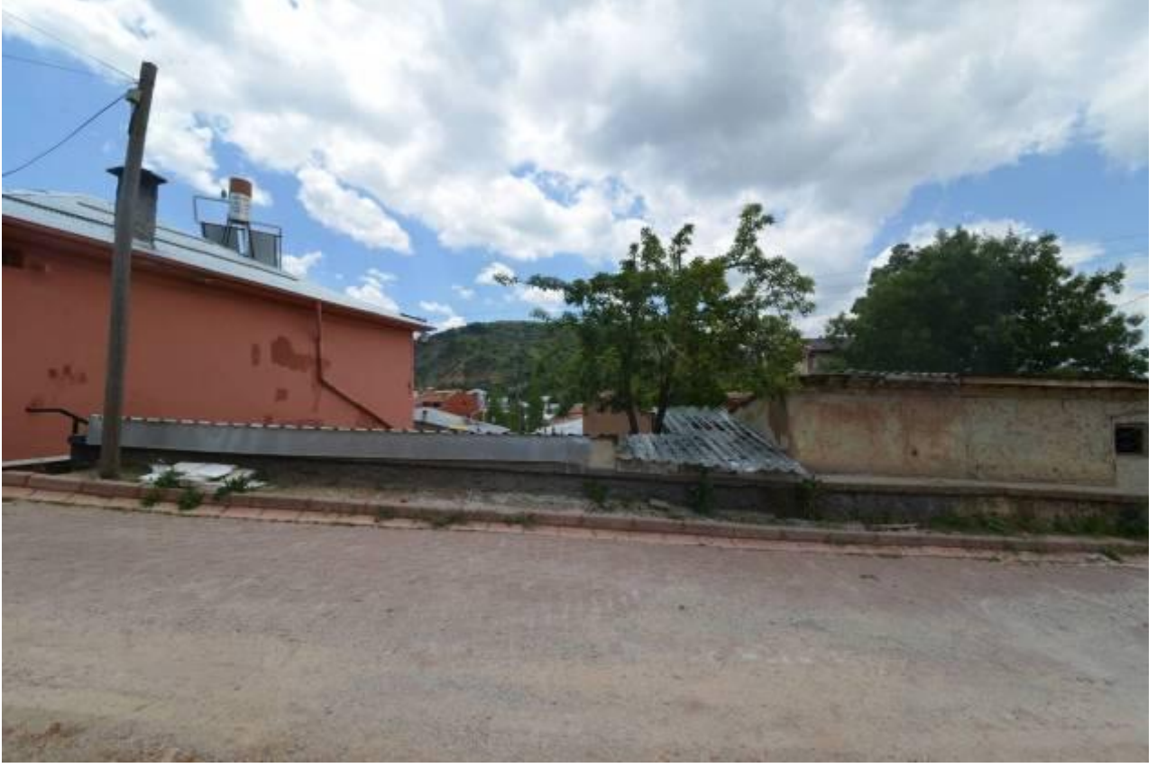
Fotoğraf:103- Küllüpınar Caddesinde 134/1 Parseldeki Yapı
