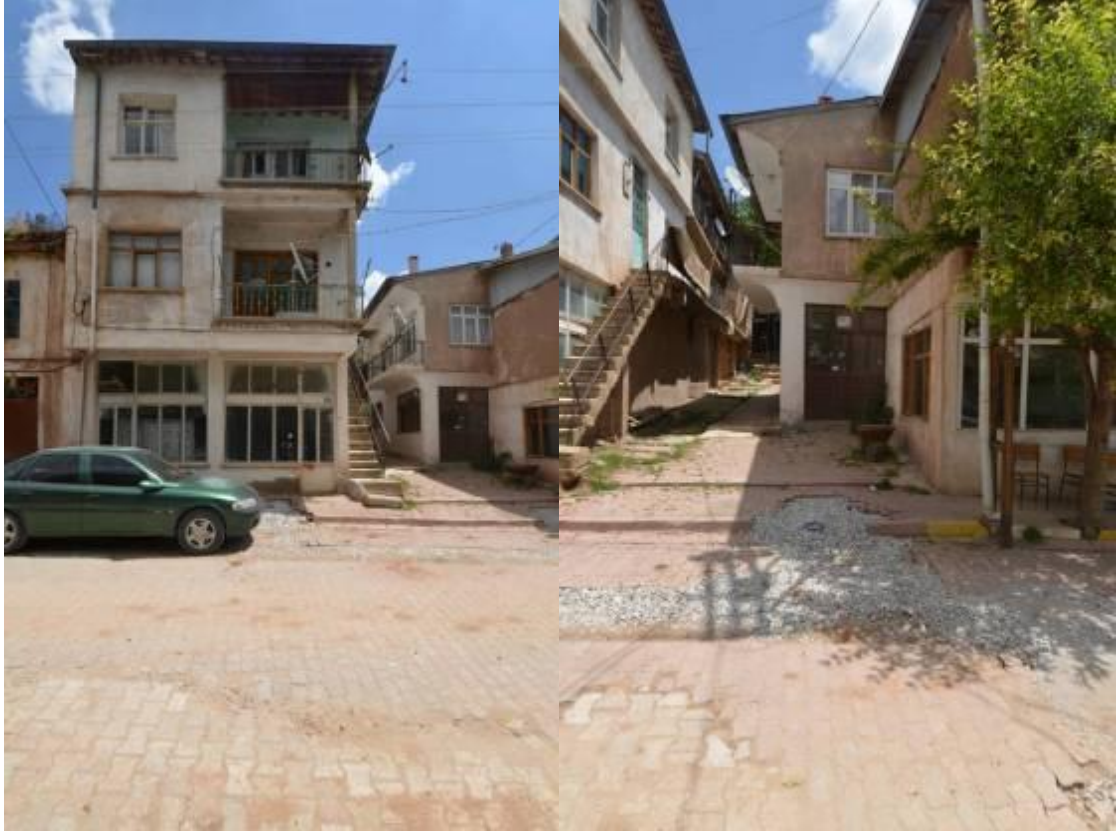
Fotoğraf:134- Başara Caddesi Üzerinde Yer Alan 17/A Numaralı Yapıdan Görünüş
