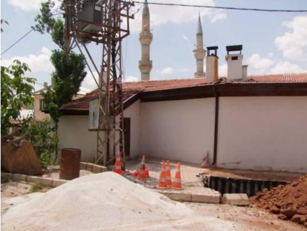
Fotoğraf:155- Başara Caddesi Üzerinde Yer Alan 615/1 Parselinde Yapıdan Görünüm
