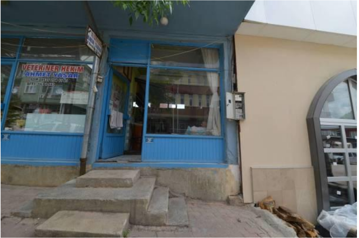
Fotoğraf:178- Hastane Caddesinde Yer Alan 3/F Numaralı Yapıdan Görünüm
