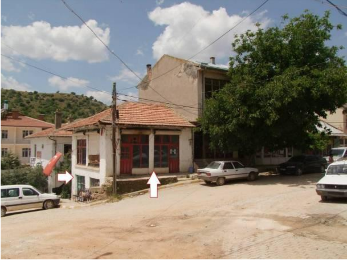
Fotoğraf:153- Başara Caddesi Üzerinde Yer Alan 121/10 Parselinde Yapıdan Görünüm
