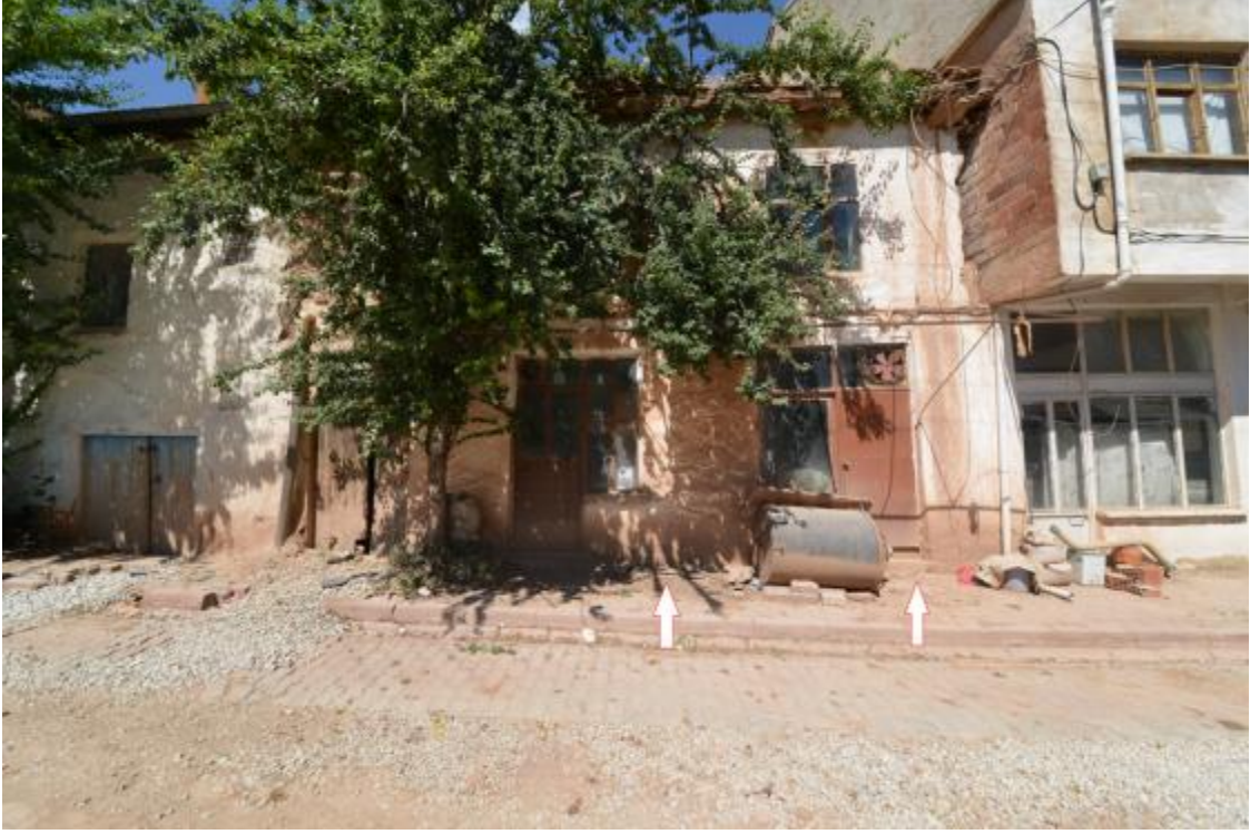
Fotoğraf:132- Başara Caddesi Üzerinde Yer Alan 15/A Numaralı Yapıdan Görünüş
