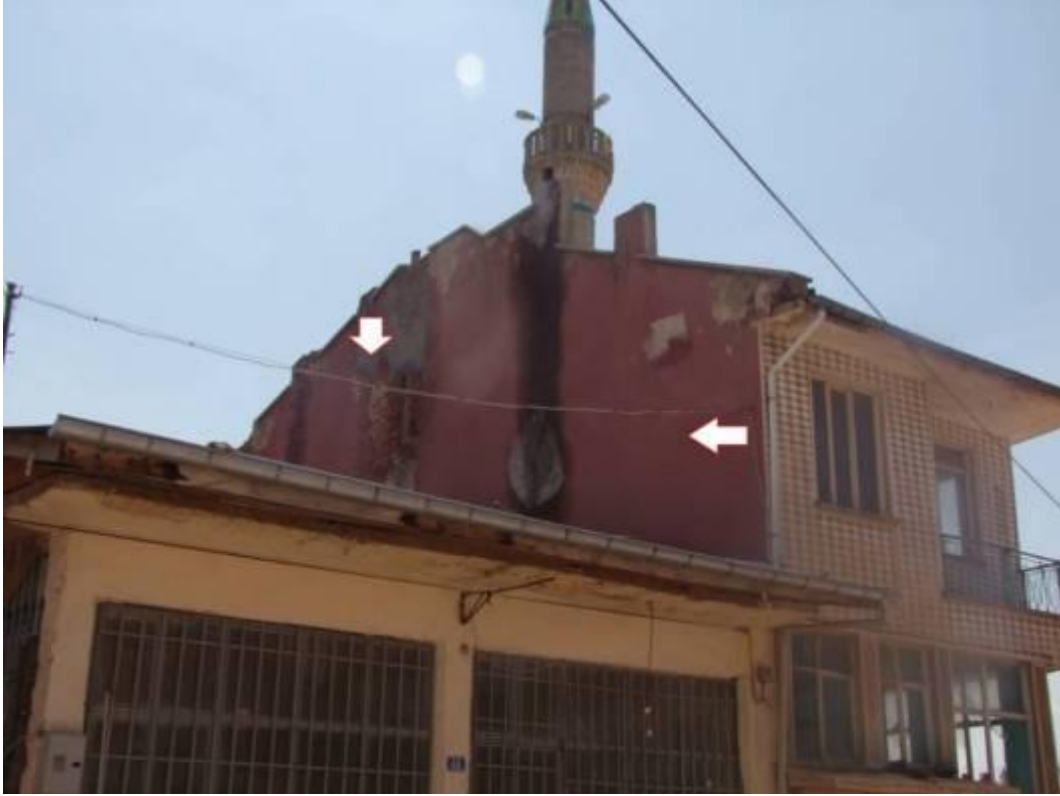
Fotoğraf:122- 6-6 Cephesinde ki Yapının Duvar Yüzeyleri
