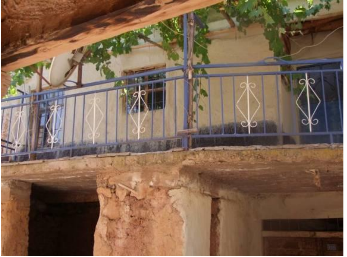
Fotoğraf:114- 6-6 Cephesi 22/A Numaralı Evin Balkonundan Görünüş
