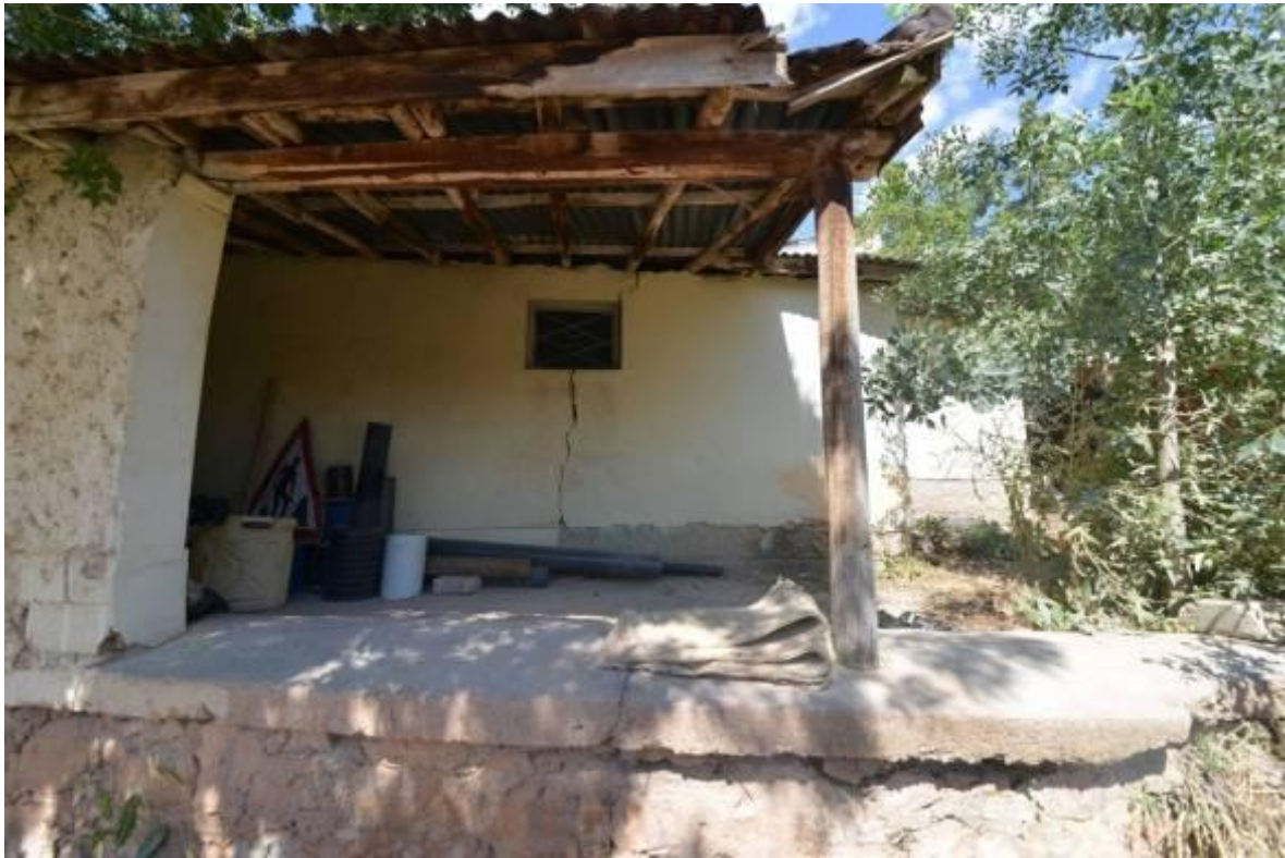
Fotoğraf:125- Başara Caddesi Üzerinde Yer Alan 18/A Numaralı Yapıdan Görünüş
