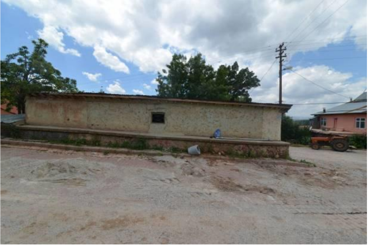
Fotoğraf:102- Küllüpnar Caddesine Bakan 134/2 Parselde Yer Alan Yapının Görünüşü
