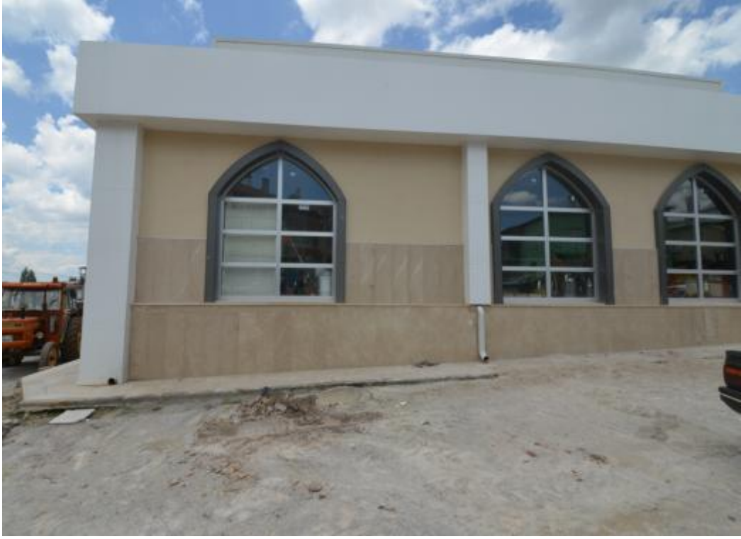
Fotoğraf:164- Atatürk Caddesi Üzerinde Yer Alan 116/1-3 Parseldeki Yapıdan Görünüm
