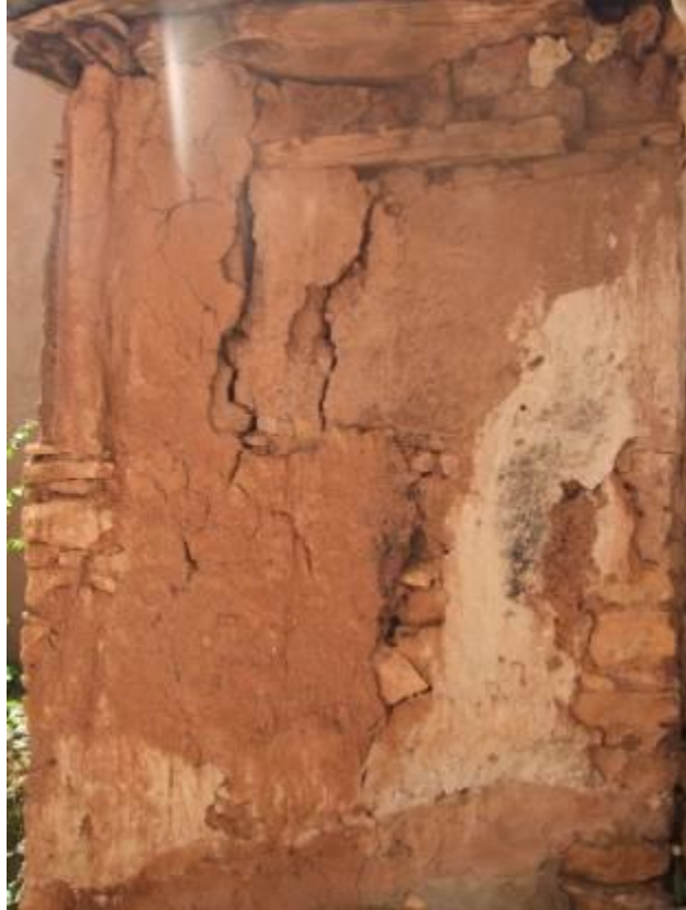
Fotoğraf:119- 6-6 Cephesi 1/A Numaralı Evinden Alt Giriş Bölüm Duvarı
