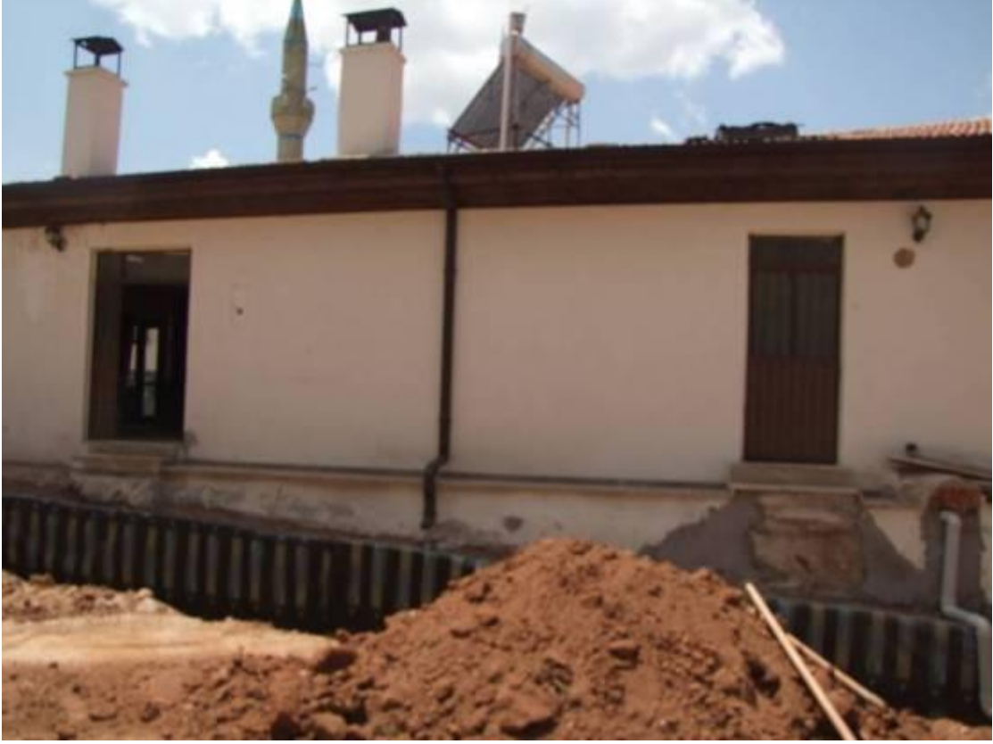
Fotoğraf:156- Başara Caddesi Üzerinde Yer Alan 615/1 Parselinde Yapıdan Detayı
