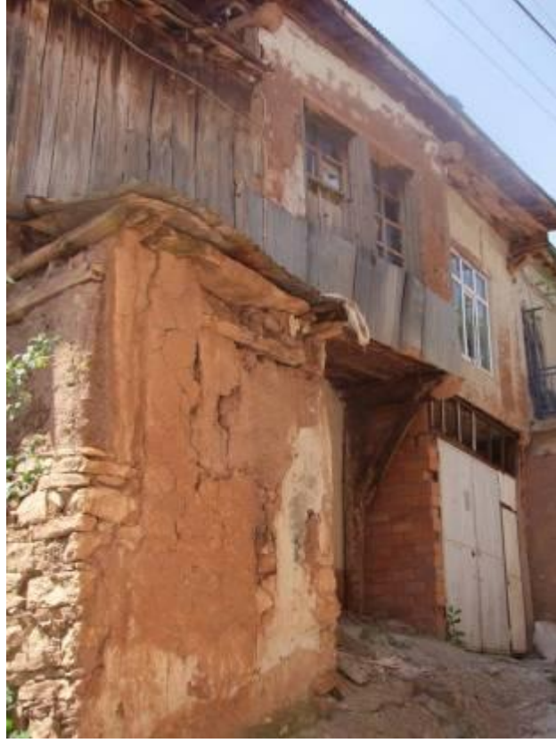
Fotoğraf:116- 6-6 Cephesi 1/A Numaralı Evinden Görünüş
