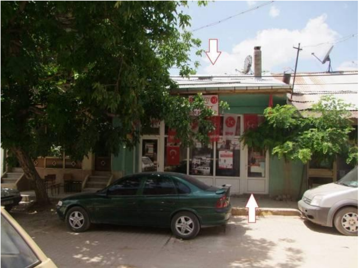
Fotoğraf:150- Başara Caddesi Üzerinde Yer Alan 121/7 Parselinde Yapıdan Görünüm
