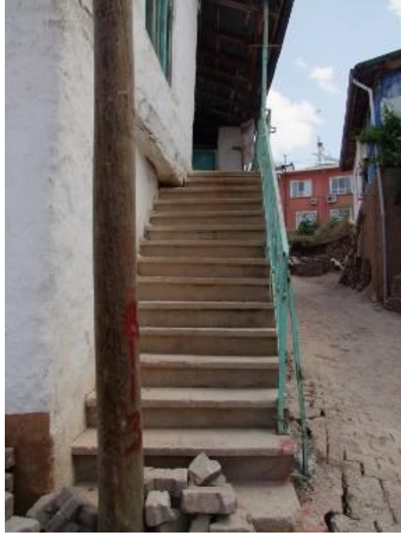
Fotoğraf:69- Konya Caddesi Üzerinde 124/5 Parselinde Yer Alan Yapının Çıkış Merdivenleri
