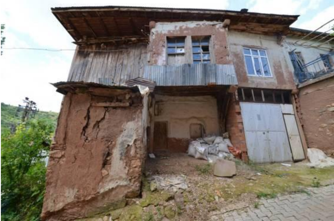
Fotoğraf:117- 6-6 Cephesi 1/A Numaralı Evinden Görünüş
