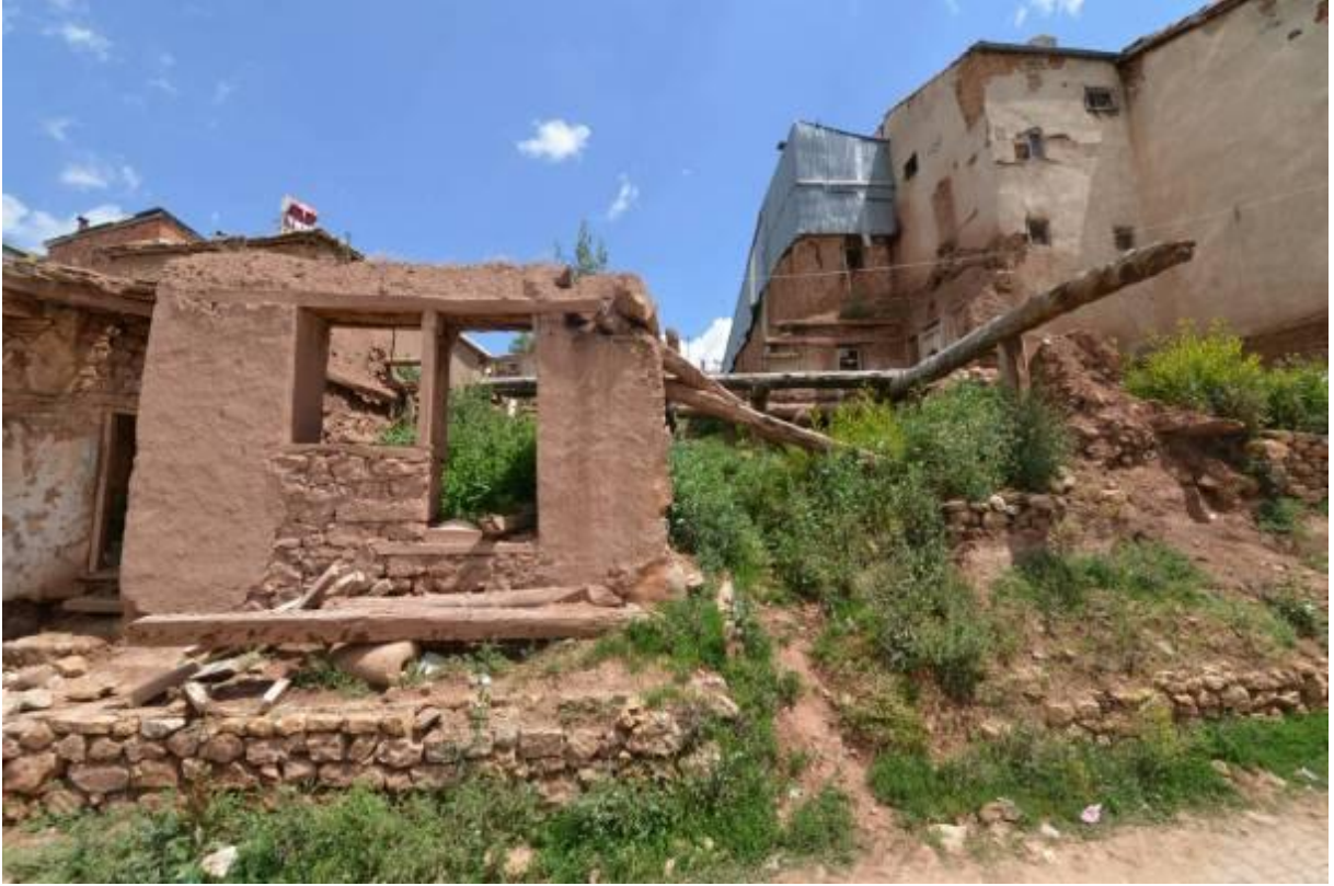
Fotoğraf:141- Başara Caddesi Üzerinde Yer Alan 3/A Numaralı Yapıdan Görünüş
