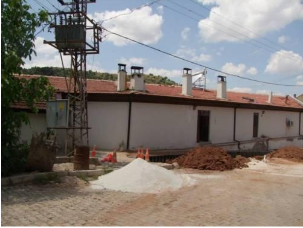
Fotoğraf:154- Başara Caddesi Üzerinde Yer Alan 615/1 Parselinde Yapıdan Görünüm
