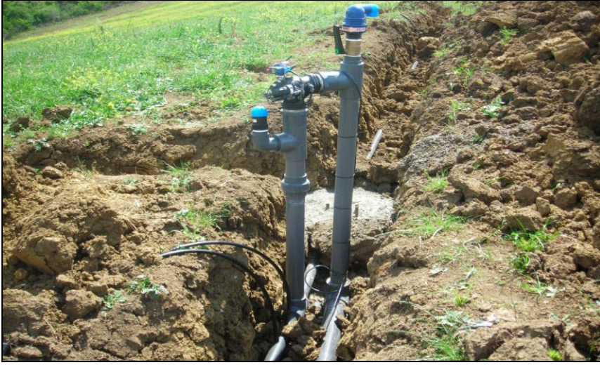
Şekil 5 Hava boşaltma vanası(vantuz)
