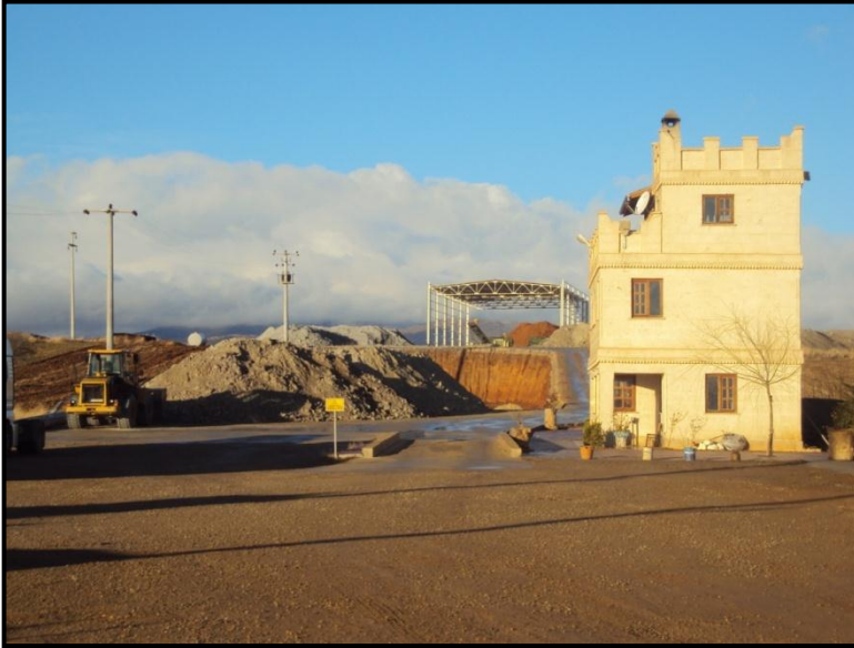
Şekil 7.5. Tokluoğlu Madencilik'e ait öğütme tesisi ve kil zenginleştirme tesisi proje yeri.
