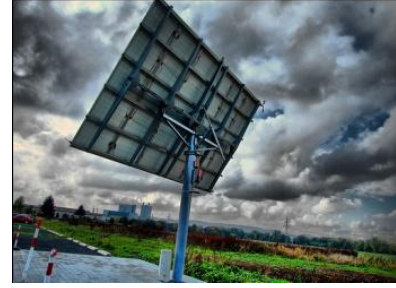
Şekil 2.10. İzleyici Montaj Seti Uygulaması
