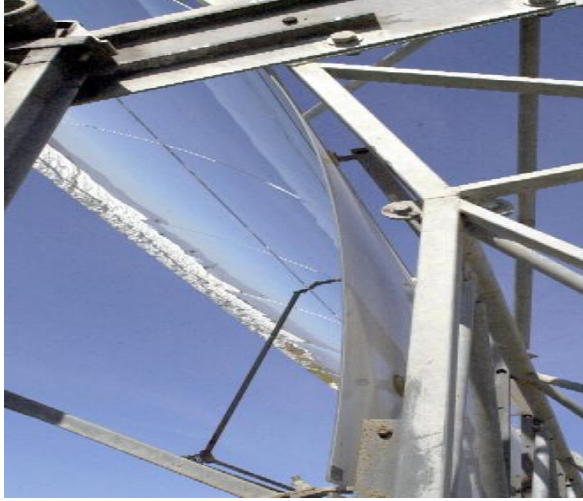
Şekil 2.19. 4 mm Kalınlığında CSP Aynası
