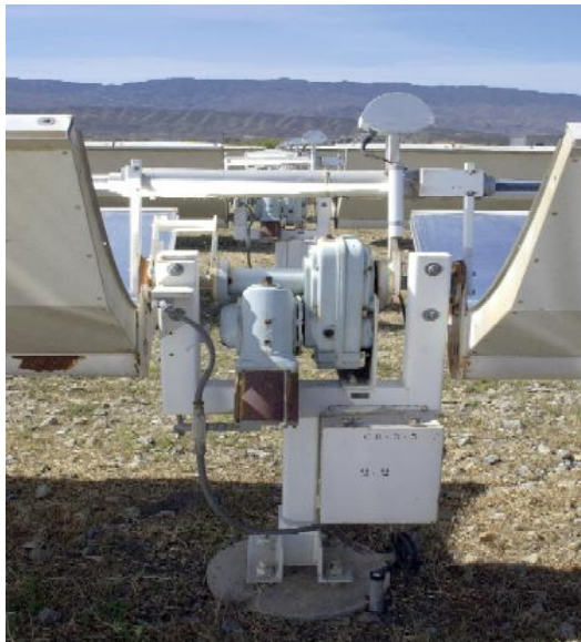
Şekil 2.22. İzleme Sisteminin Elektrik Motor – Şanzıman Kısmı
