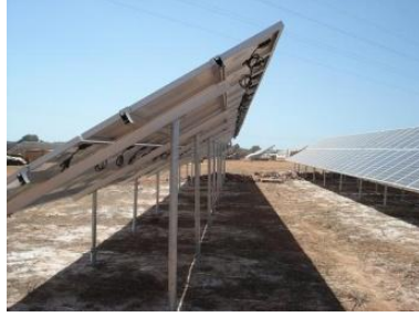
Şekil 2.9. Sabit Montaj Seti Uygulaması
